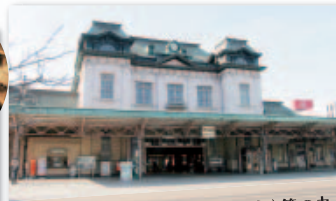
JR門司港駅 1914年(大正3年)築の九州最古の木造駅舎。鉄道駅舎で初の国重要文化財に指定されています。ネオ・ルネッサンス様式と呼ばれるデザインは、九州の玄関口として「門」をイメージしています。
